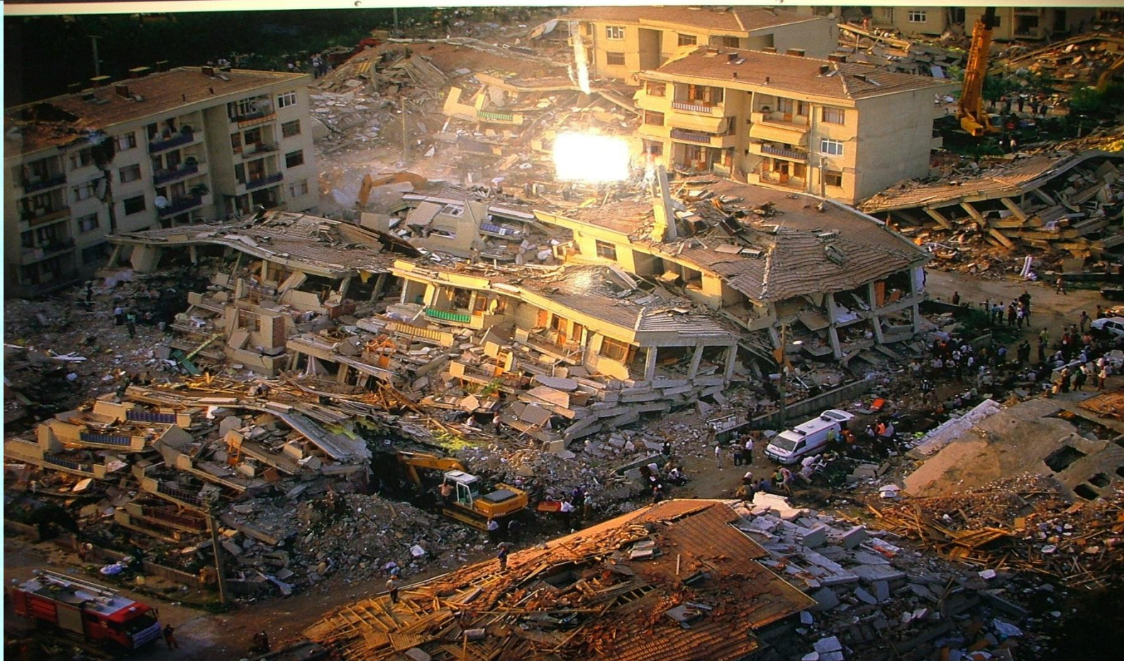
Будівлі, пошкоджені в результаті Мармурового землетрусу 1999 року
